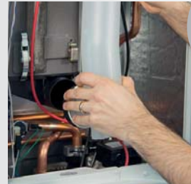
Rimozione collettore fumi
