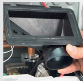
Ispezione raccolta condensa
