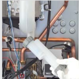
Rimozione sifone condensa
