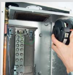
Rimozione del sistema di combustione completo
