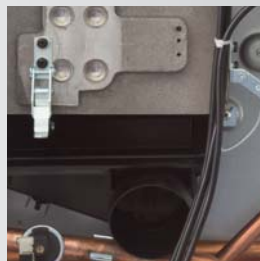
Sblocco raccolta condensa
