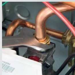
Rimozione del sistema di serraggio della tubazione
