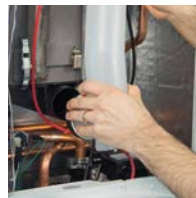
Rimozione collettore fumi
