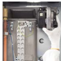
Rimozione del sistema di combustione completo
