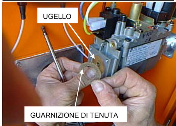
Figura 39 – Sostituzione ugello.
