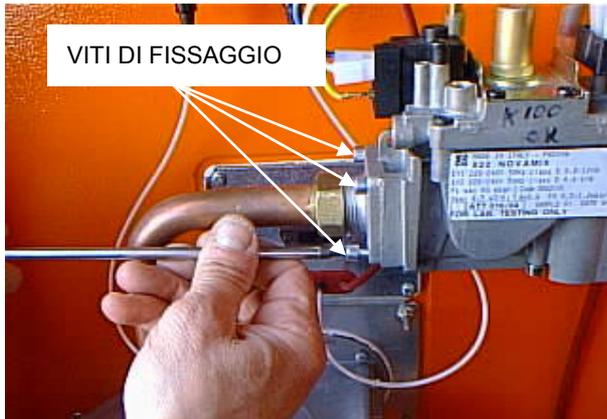
Figura 36 – Viti di fissaggio flangia gas.
